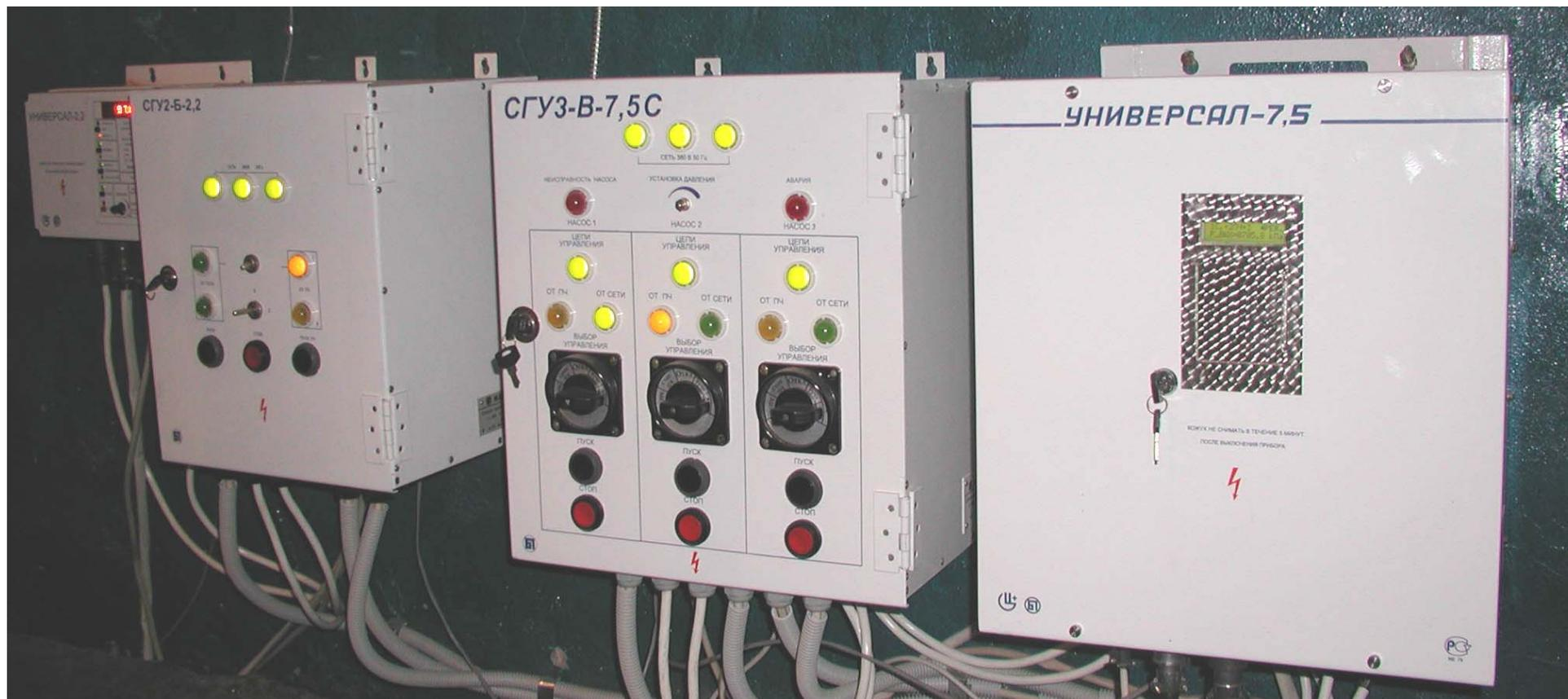
Рис.1. Энергосберегающий комплект в составе “Универсал-7,5(В)”, СГУЗ-В-7,5(С), “Универсал-2,2(Б)”, СГУ2-Б-2,2.
